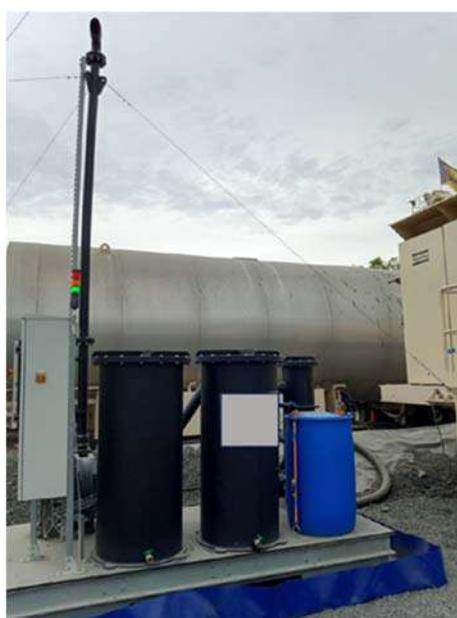
*Figure 31. Exemple de filtre à charbon actifs équipant les événements des cuves de bitume*
