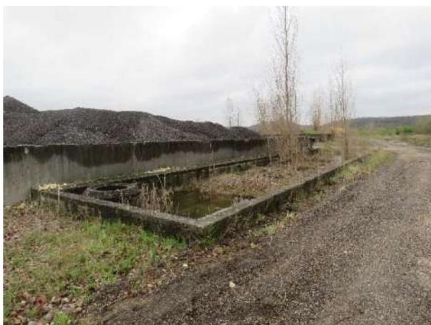
*Figure 12. Bassin de collecte des eaux au nord-ouest du site, équipé d'un système de filtration*
