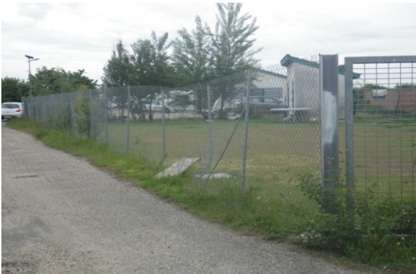
L'accès au site et la micro-station d'épuration.
