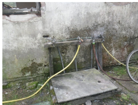
Les alimentations en eau sont maintenant contrôlées à l'aide d'une robinetterie.
